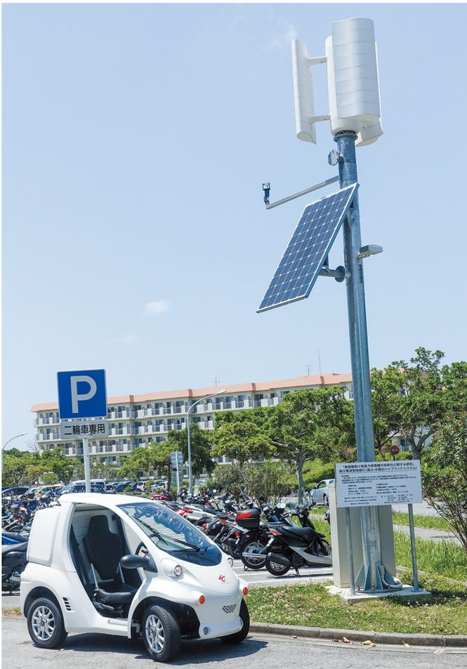
■ 琉球大学工学部入口に設置されている垂直小型風車。地域企業と共同開発した。大学には小型電気自動車やゼロエネルギーハウスなども備えられていて、再エネで電力をつくる、貯める、使うというすべてのプロセスを実際的に研究する環境が整っている。
